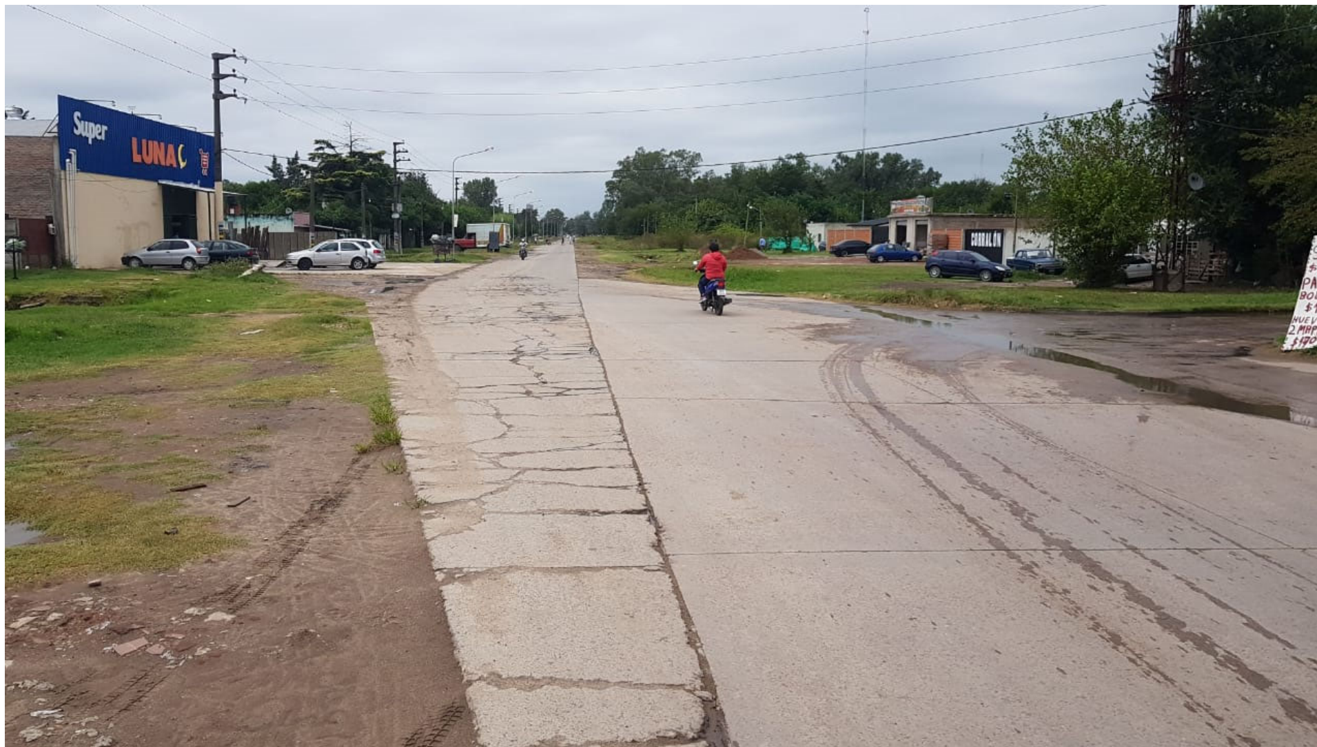
Foto 6: cambio en eje de la traza de la Av. Balbín, respecto al tramo en el cual presenta cordón-cuenta.
