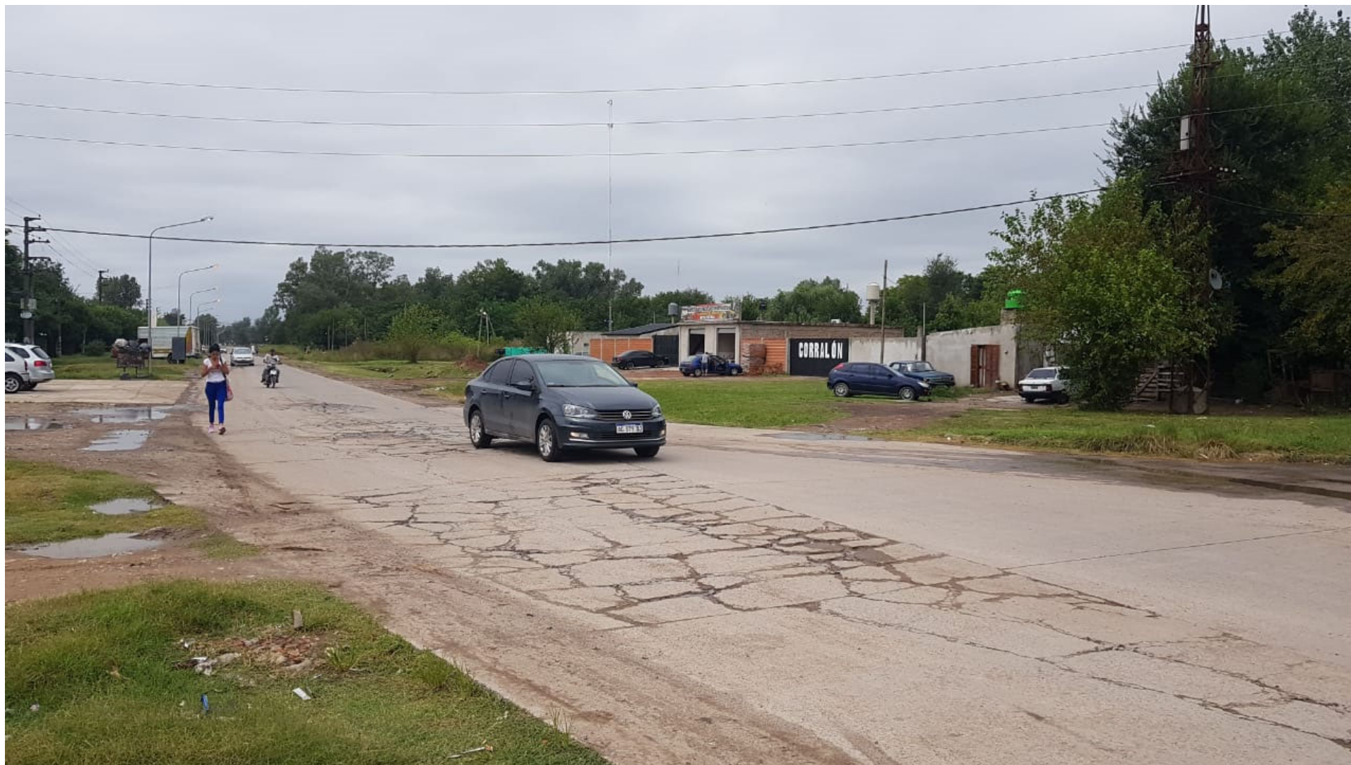
Foto 5: Carpeta de hormigón muy deteriorada en la Av. Balbín, en el tramo donde no presenta cordón-cuneta, entre las calles Caseros y Del Canal.
