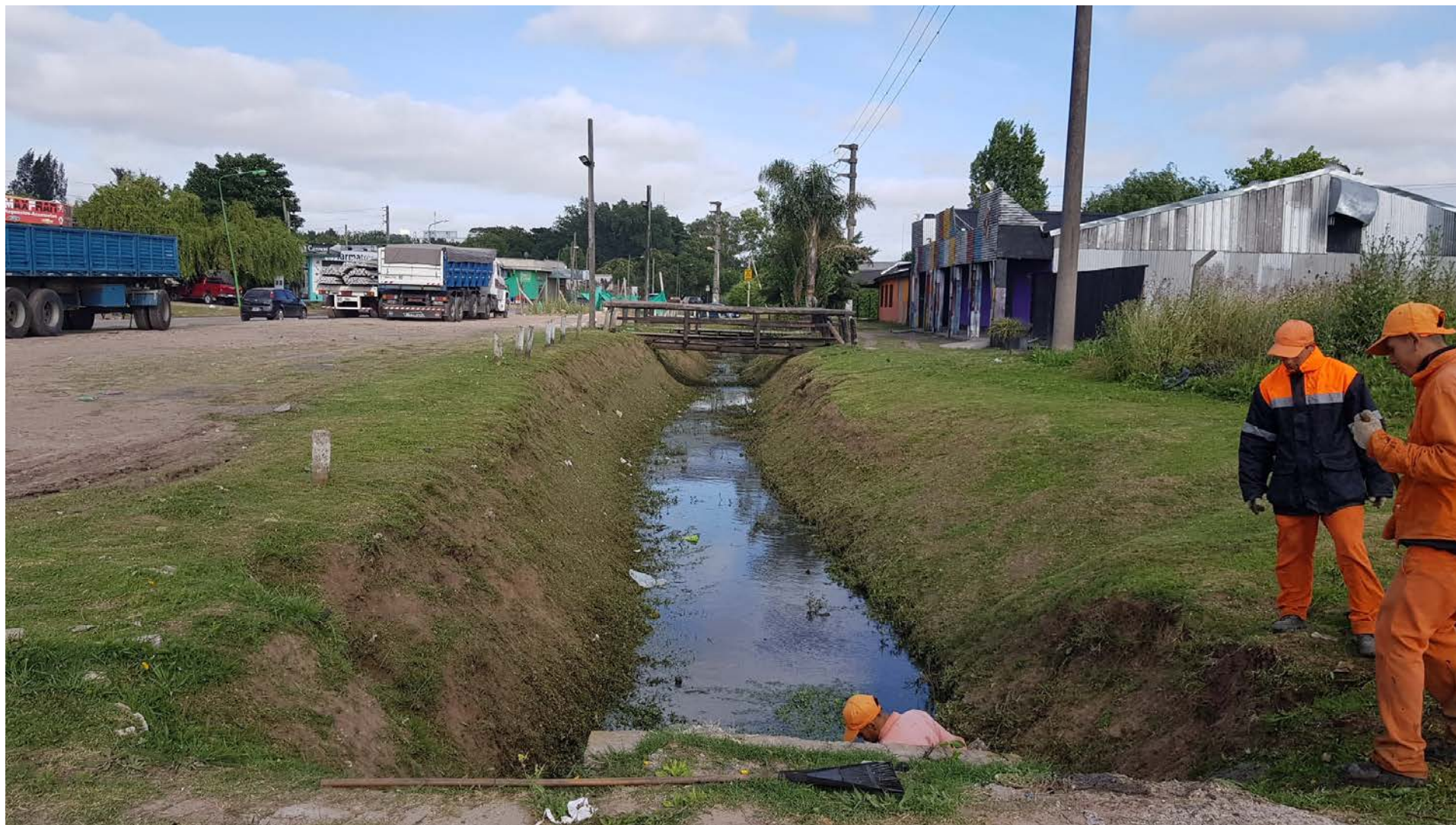
Foto 2: zanjón existente en la Av. Balbín.
