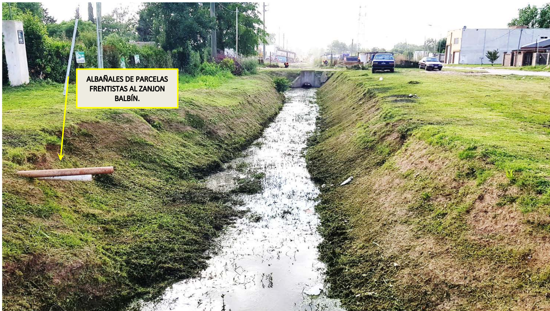
Foto 1: zanjón existente en Av. Balbín.
