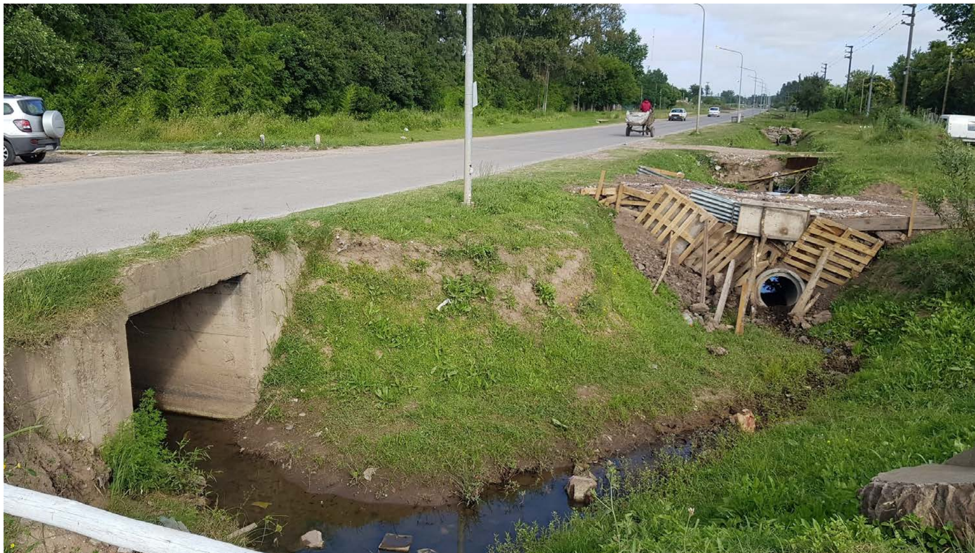
Foto 4: zanjón existente en la Av. Balbín, en la alcantarilla de cruce y conexión con el canal sin revestir de la calle El Canal.
