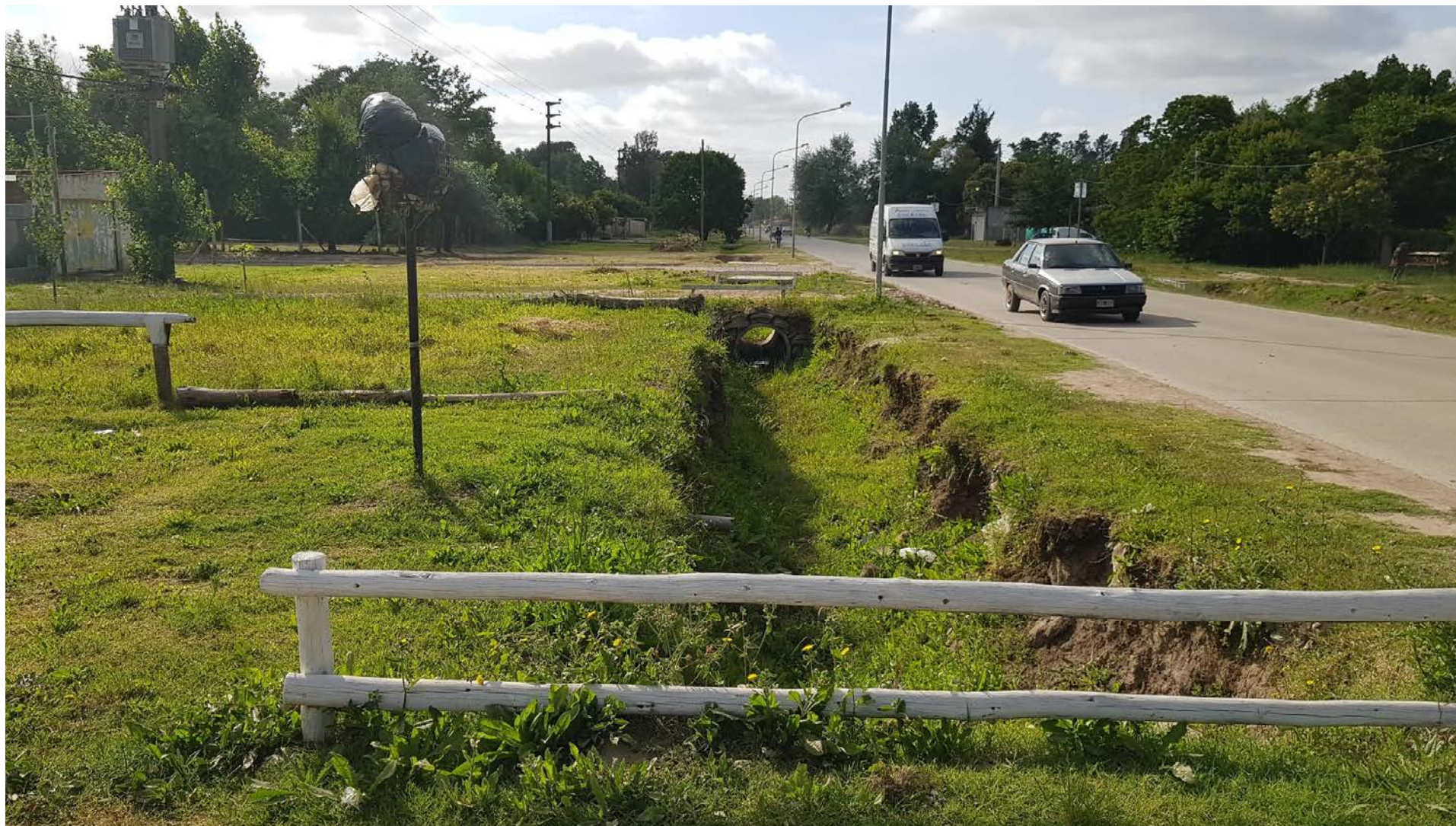
Foto 3: zanjón existente en la Av. Balbín, en el tramo donde no presenta cordón-cuneta.
